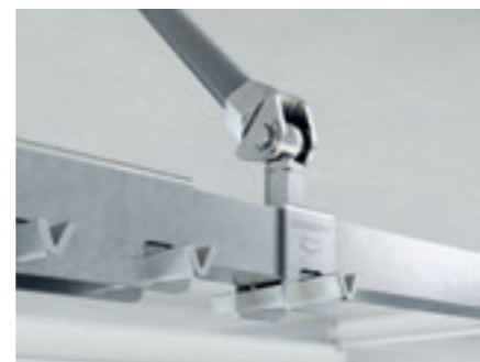
Montagekilerne er lette at slå i og kræver ingen specialværktøjer.
